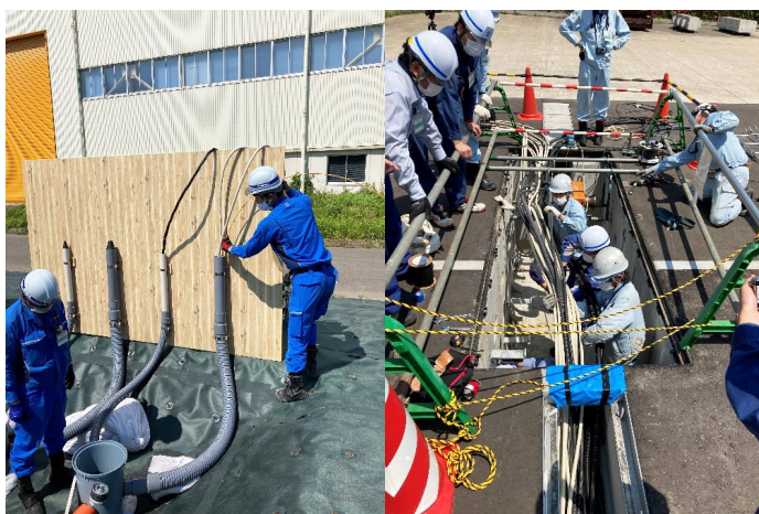
国土交通省 国土技術政策総合研究所での一管共用引込み方式の検証試験
