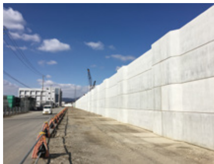
内湾に建設されている7.2mの防潮堤
