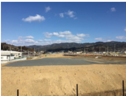
盛り土をして造成中の被災地
