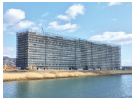
建設中の被災者用公営住宅
